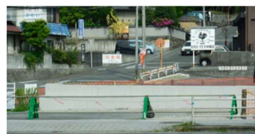
橋梁工事中の六銭橋（南側）付近
